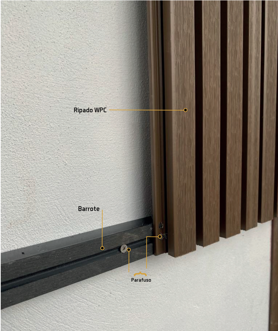
*Kit Fixação - Parede Maciça (Bucha N8)
